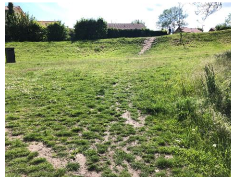
État du sentier de gauche
