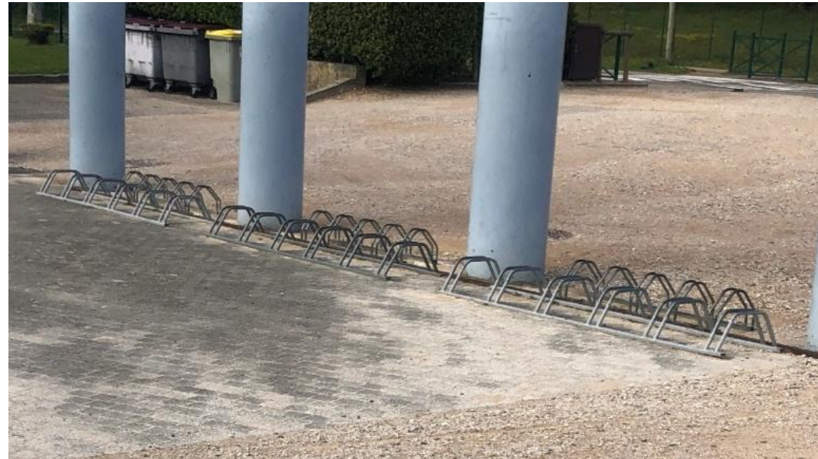
Seul stationnement existant peu adapté puisqu'il permet difficilement d'accrocher le cadre et la roue, inutilisable pour les grosses roues et peut tordre les plus fines
