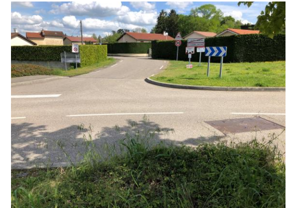
Absence de traversée au niveau du Chemin au Pré
